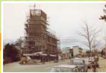
工事中の「サンドラックビル」道路脇に止められた車が時代を感じさせます。現在は佐藤定人さんの息子さん「佐藤皮膚科」を開業。
